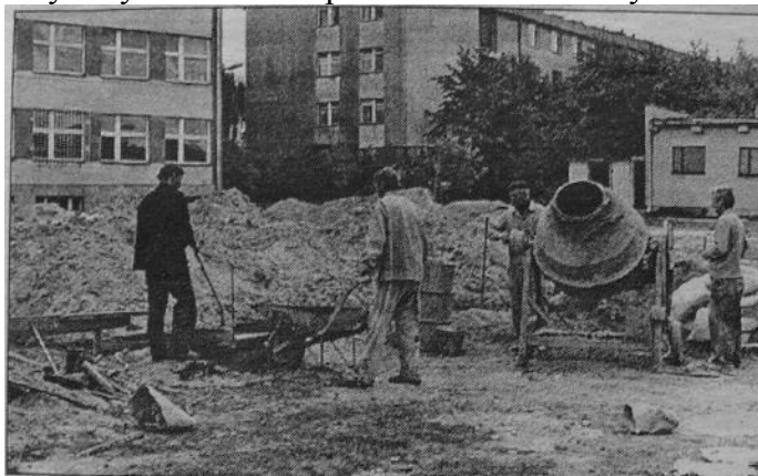
W Zespole Szkół Zawodowych przy ul. Polnej 13 w Poddębicach trwają prace przy budowie sali gimnastycznej. Na razie powstały jedynie wykop pod ławy fundamentowe. Przed nastaniem mrozów fundamenty zostaną zalane betonem. Prace posuwają się dość wolno, gdyż sala budowana jest ze środków społecznych. W czynnie społecznym wykonywanych jest też wiele prac. Przy budowie hali pracują również, w ramach robót publicznych, poddębicki bezrobotni.
